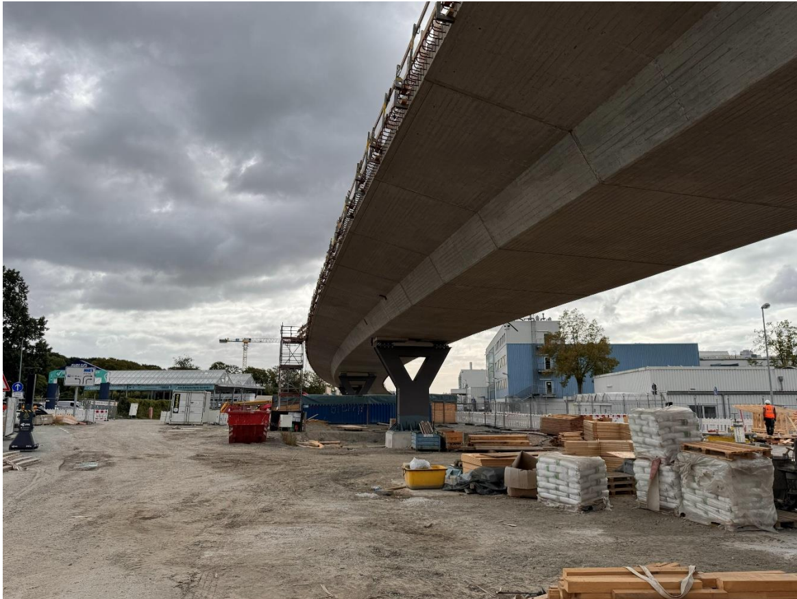
A 281 BA 2/2: Verlängerung Hochstraße im Bereich Neuenlander Ring
