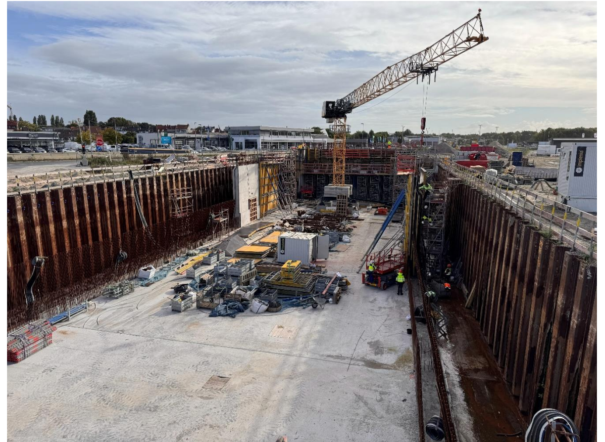
A 281 BA 2/2: Tunnel-/Trogbauwerk in Richtung Knotenpunkt Neuenlander/Kattenturmer Heerstraße
